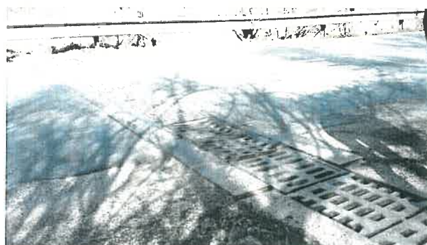
Obr.10 a,b Fungující migrační podchod navádějící obojživelníky na lokalitu PP Střelická bažinka
