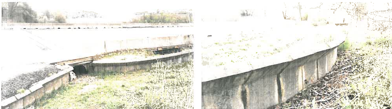
Obr.11 a,b Fungující migrační podchod navádějící obojživelníky na lokalitu PP Žebětínský rybník
