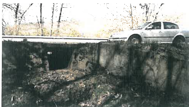
Obr.10 a,b Fungující migrační podchod navádějící obojživelníky na lokalitu PP Střelická bažinka
